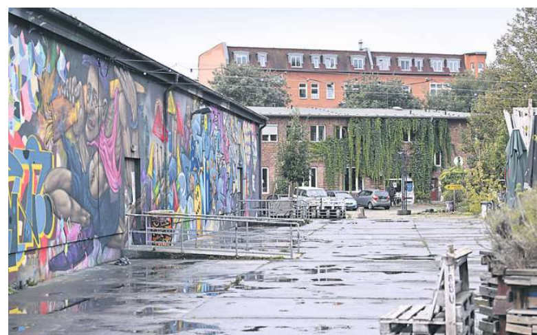
Auf das Dach des Clubs Spartacus (links) sollen Solar- und Windkraftanlagen installiert werden.
